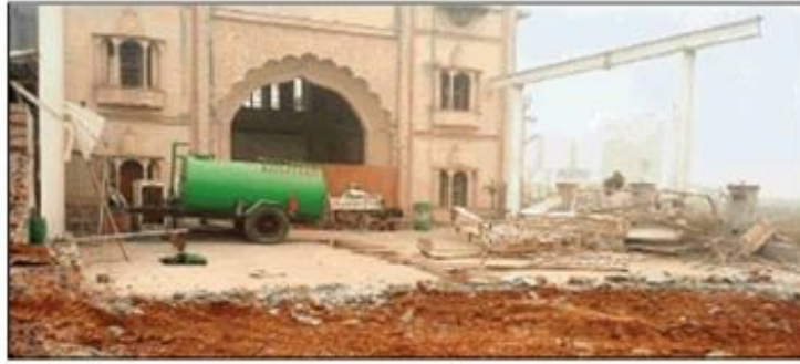
फोरलेन के निर्माण के लिए सतलोक आश्रम के गेट तक कर दी गई खुदाई।
